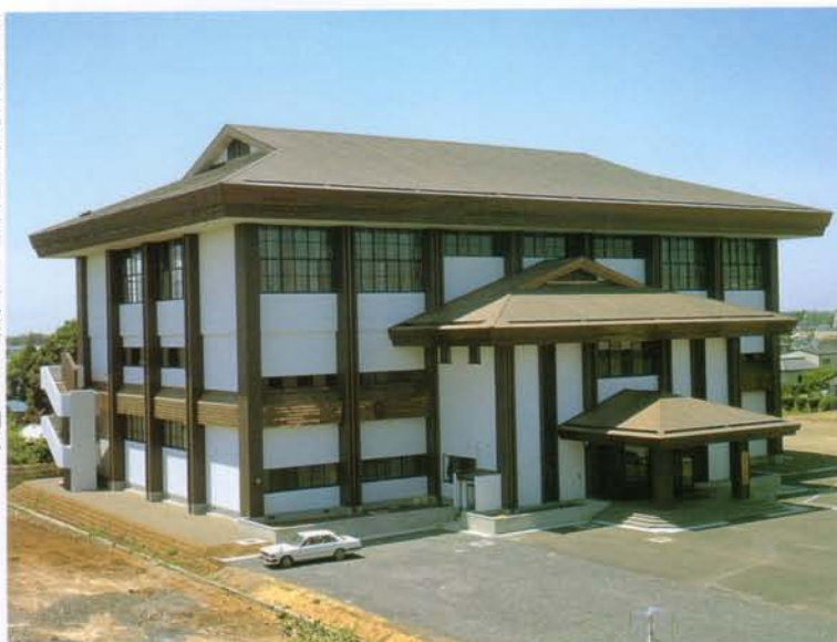
真岡市体育館兼柔剣道場 W折段葺300銅板
