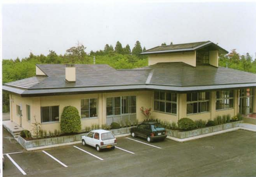
壬生町立壬生北小学校給食棟 W折段葺300フッ素鋼板
