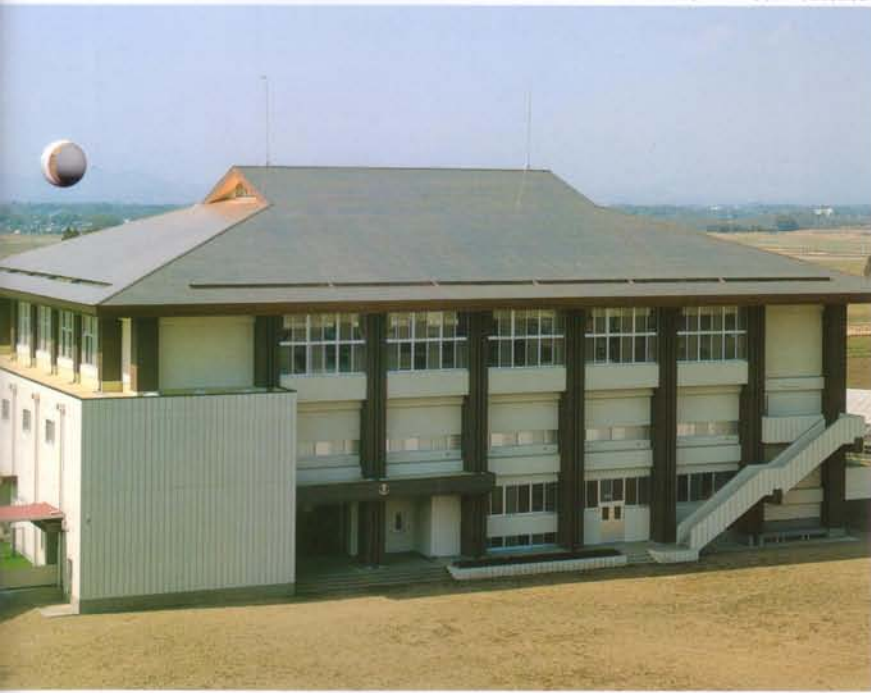
国分寺中学校体育館 W折段葺200銅板
