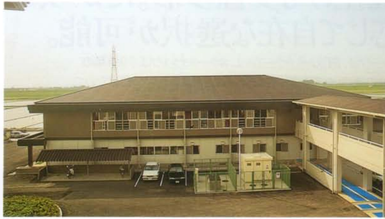
小山市立乙女中学校体育館 W折段葺300着色亜鉛鉄板(つや消)
