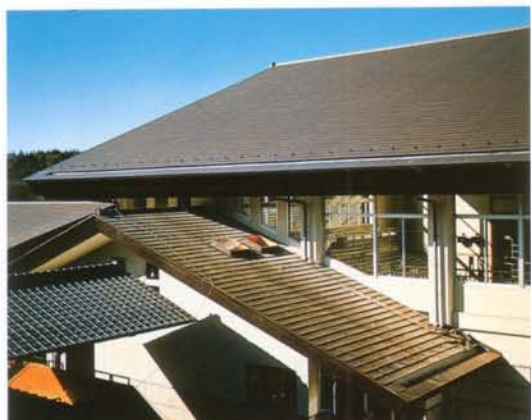
茂木町立逆川小学校体育館 W折段葺300フッ素鋼板
